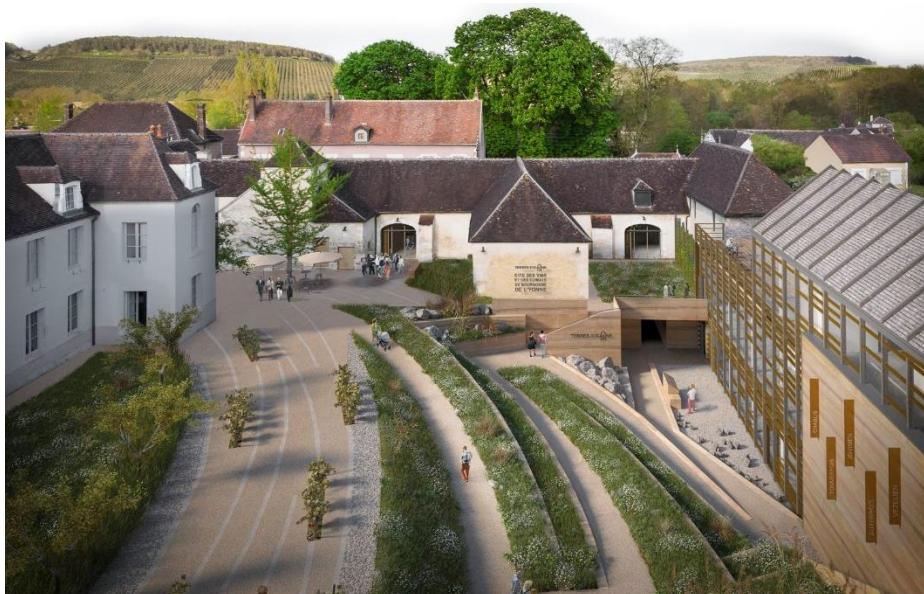
The proposal for the Cité des Vins et des Climats de Bourgogne in Chablis ©BIVB / Correia Architectes, Emmanuel
